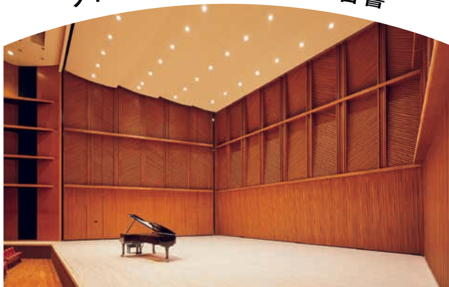
音響反射板を設置した状態。合唱や吹奏楽での利用に
